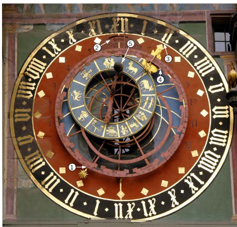
Figure 4: les principales indications données par l'astrolabe de la Zytglogge.
